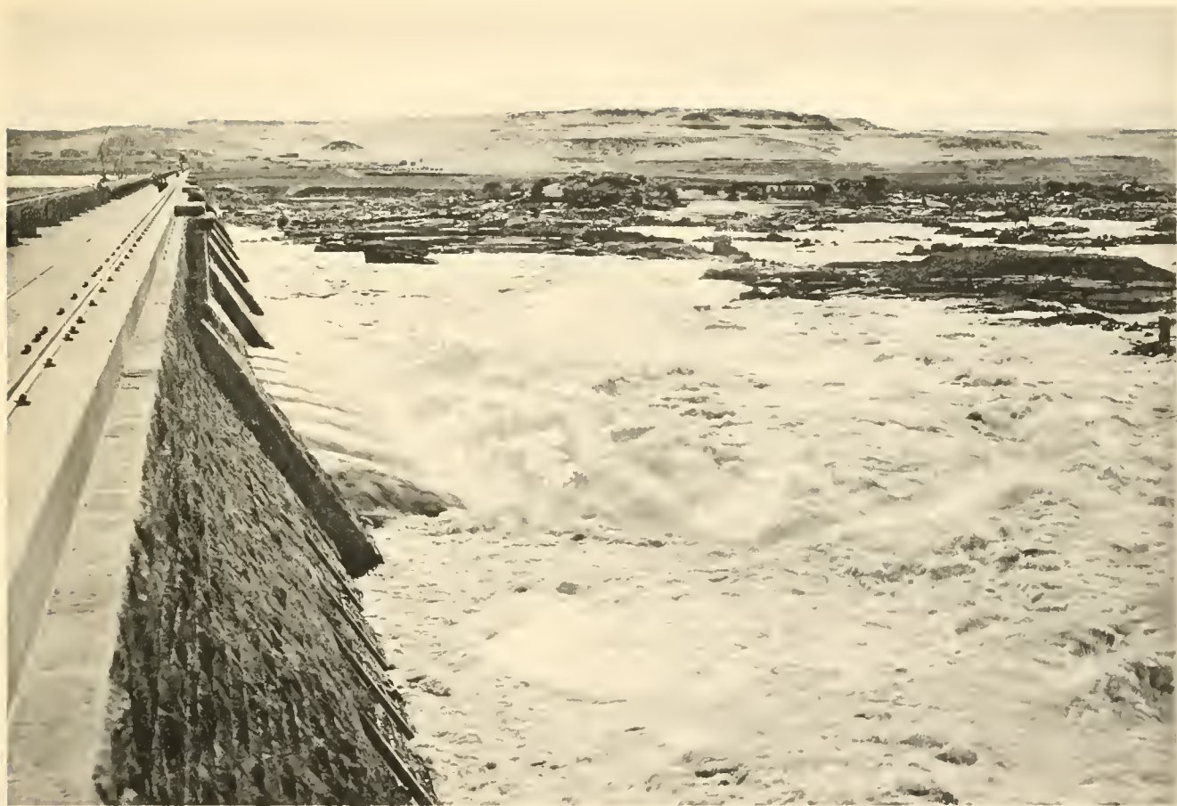
Réservoir du Nil à Assouan. The Assouan Dam.
